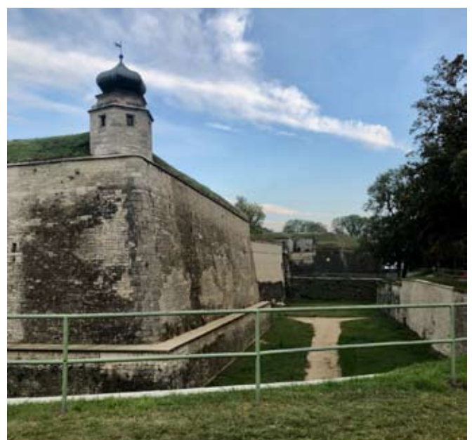
Eine Eckbastion der Wülzburg
